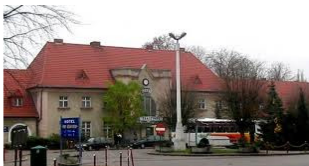
Dworzec PKP w Zbąszynku
